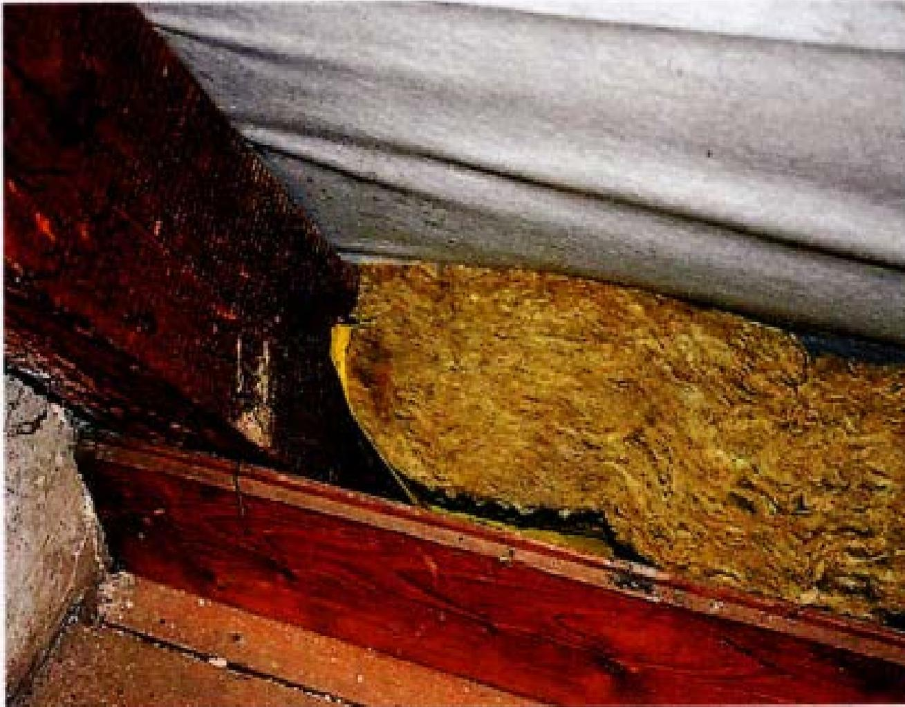
**Hohlkehlen, die wie Luftströmungskanäle wirken, können zu einem erhöhten Tauwasserausfall führen. Gleichzeitig schiebt sich die Wärmedämmung – wie gut zu sehen – nach oben und gelangt in die Belüftungsebene der Konterlatten.**
